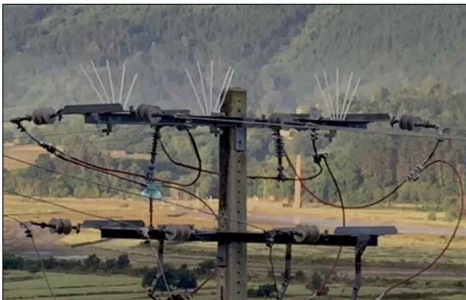
*Peines instalados en apoyos eléctricos de las inmediaciones de la torre de hacking para evitar el posado de las águilas pescadoras durante la fase de dependencia*
